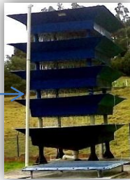
Pozo Aireación Coagulación – Flocculación
