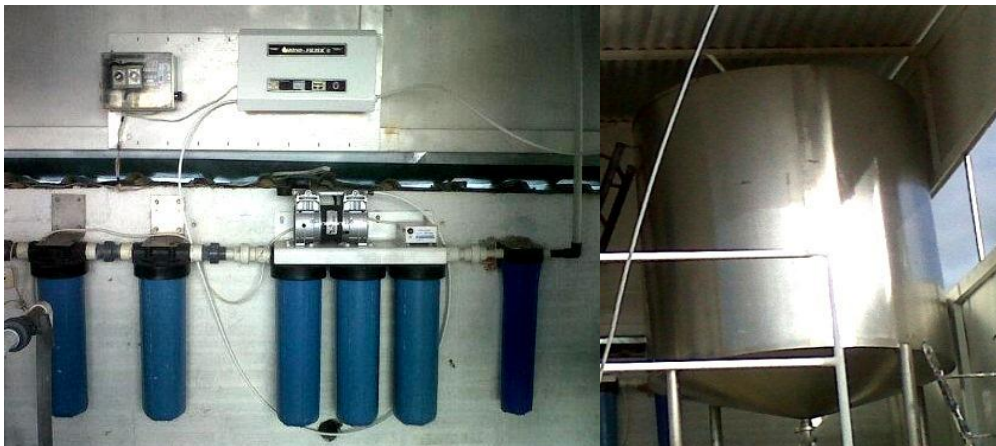
Imagen 21. Microfiltros y lámpara U.V. Imagen 22. Ozonizador.
