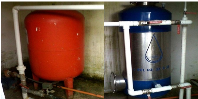
Imagen 17. Hidroflo Imagen 18. Filtro carbón activado
