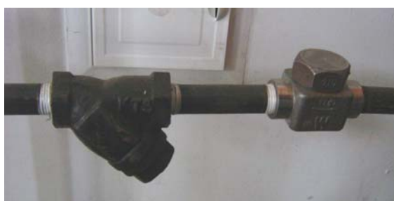
Figura 42. Montaje del filtro
