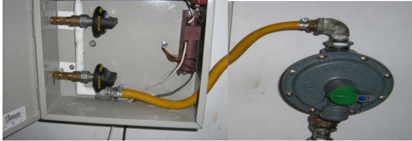
Figura 26. Montaje del regulador de gas
