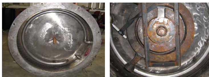
Figura 27. Montaje de los quemadores de gas en el destilador
