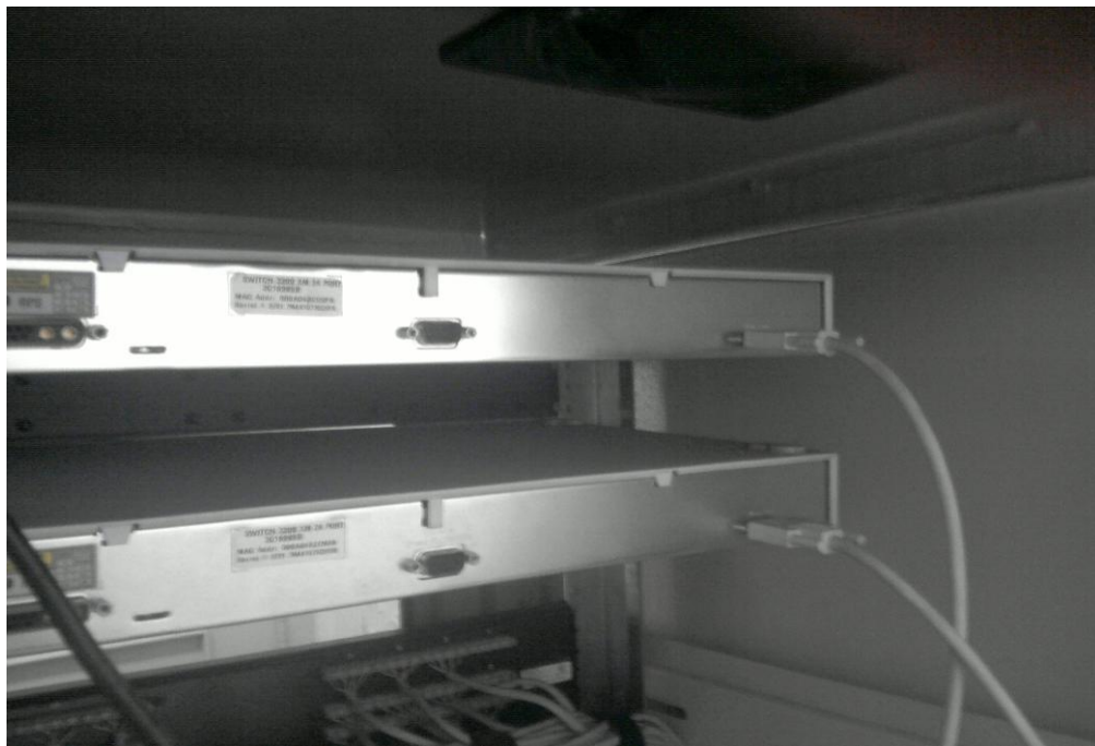
Figura 5. Apilamiento de switch 3com 3300Mx
