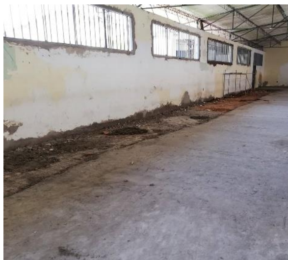
Figura 7. Mantenimiento del piso del alojamiento.
