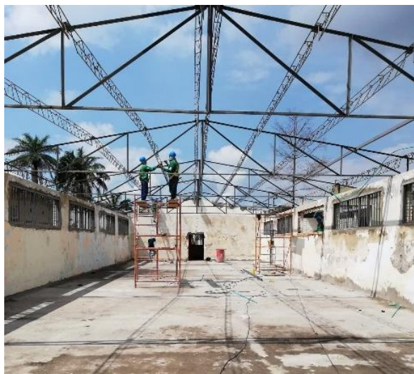
Figura 6. Cambio de cubierta, Desmonte de cubierta y aplicación pintura anticorrosiva.
