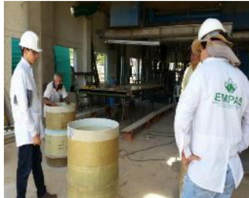
Fotografía No. 7 y 8. Seguimiento a la adecuación del tubo en fibra de vidrio para el biofiltro.
