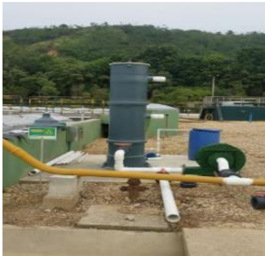
Fotografía No. 13 y 14 Seguimiento a la construcción de la unidad de Biofiltración
