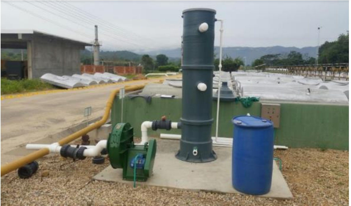
Fotografía No. 15 y 16 Montaje de la unidad de Biofiltración.
