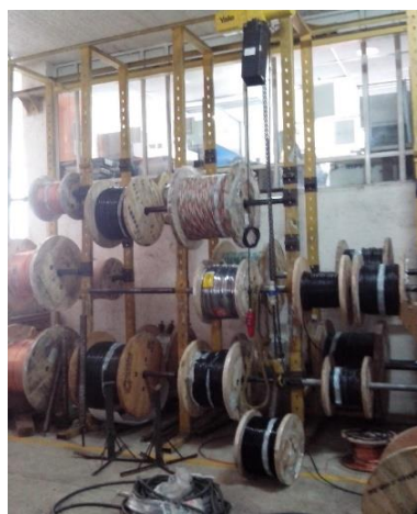
Figura 29. Estructura de cableado.
