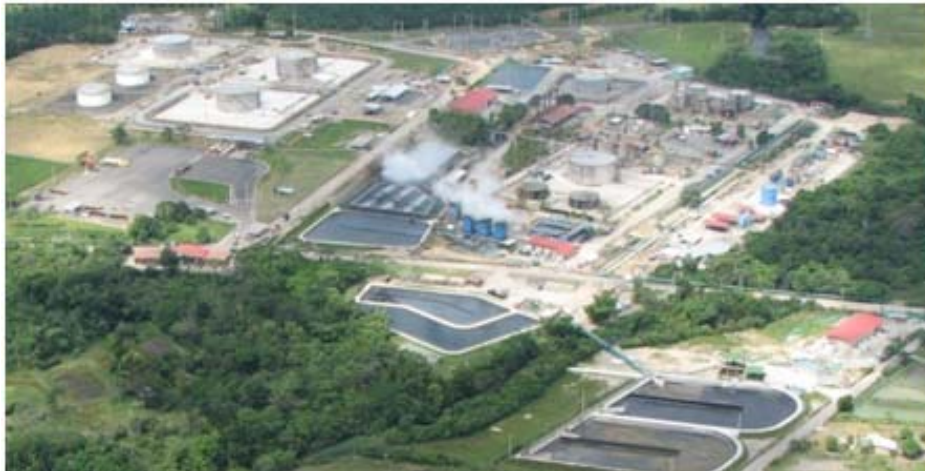
Figura 11. Estación Castilla 2 & Área de Transferencia Castilla ATC
