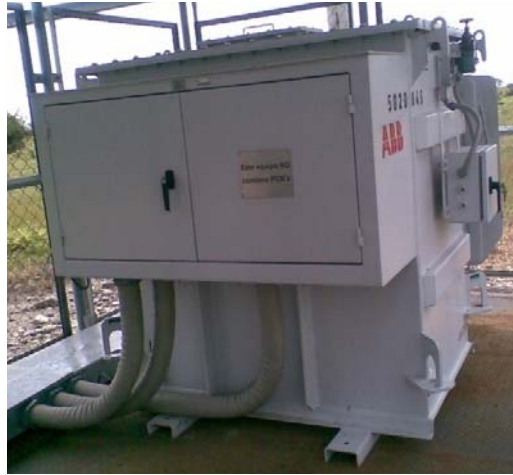
Figura 21. Transformador elevador
