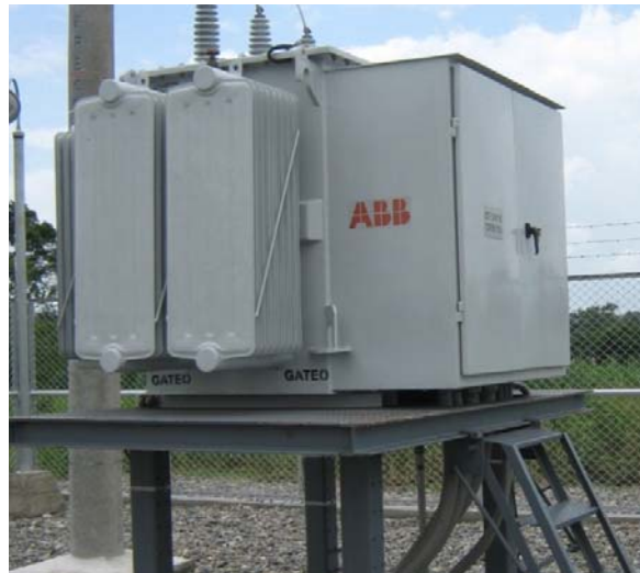
Figura 19. Transformador reductor
