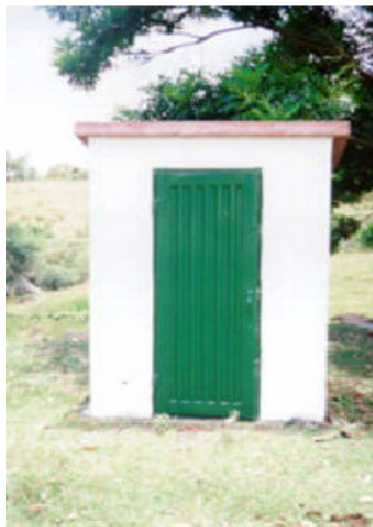
Figura 19. Fotografía de la caseta de una estación remota de la RSNC.
