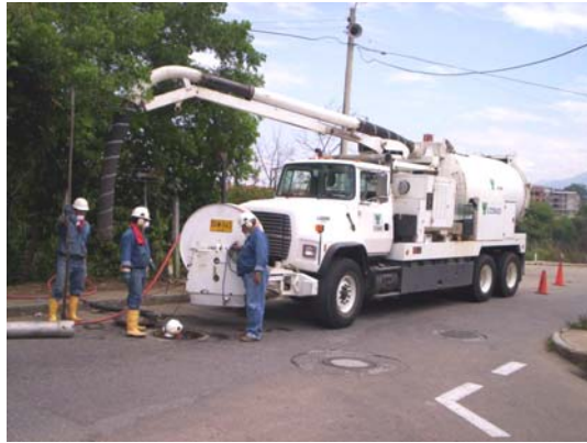
FOTO 5 EQUIPO VACTOR CDMB LIMPIEZA DE POZOS Y SUMIDEROS
