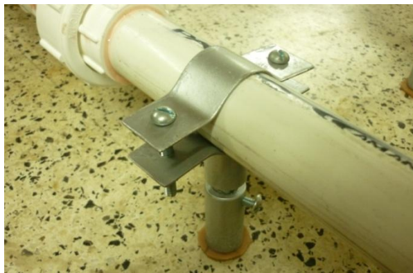
Figura 12. Soporte de tubería instalado en el banco de pruebas
