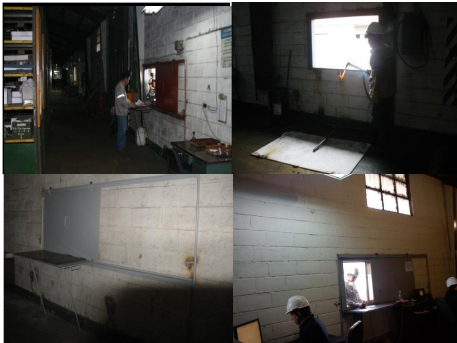
Antes durante y después ventanilla despacho de material
