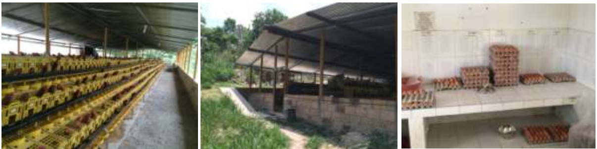
Figura 1. Instalaciones Macro Huevo S.A.S
