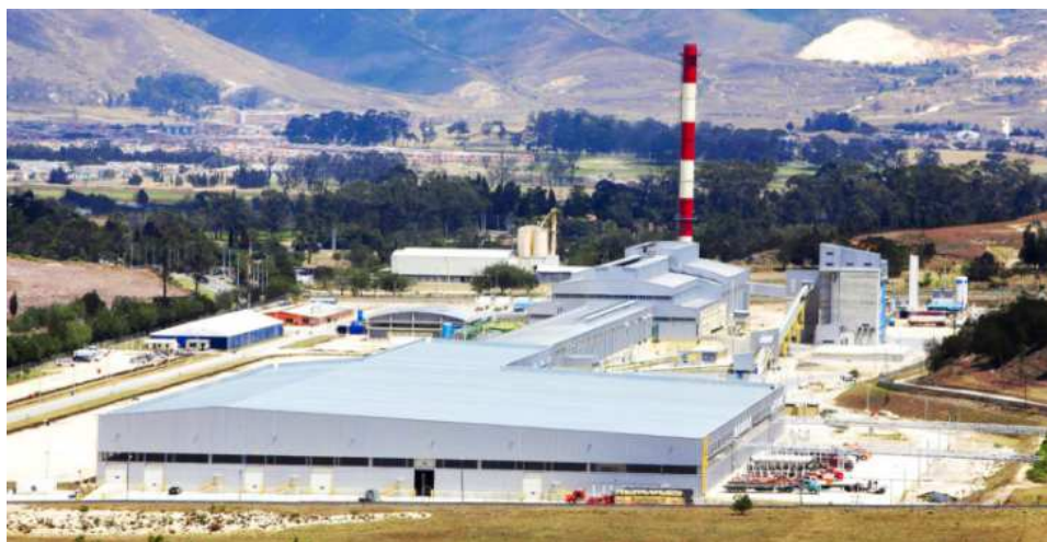
Figura 2. Planta de vidrio flotado ubicado en Soacha –Cundinamarca
