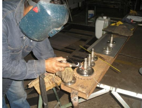
Figura 6. Soldadura de Brida a niple
