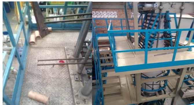
Figura 19. Antes y después de las máquinas extrusoras (aseo y pintura)
