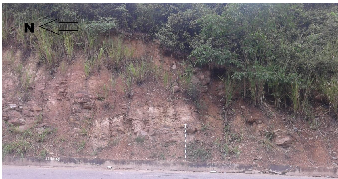
Figura 9. Afloramiento de la Formación Diamante, con alta meteorización. Por la vía Bucaramanga – La Costa.
