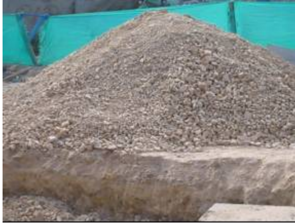
FIGURA 21. COLOCACIÓN DE SUBBASE
