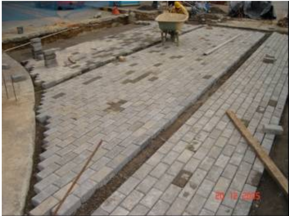
FIGURA 45. CONSTRUCCIÓN POMPEYANO
