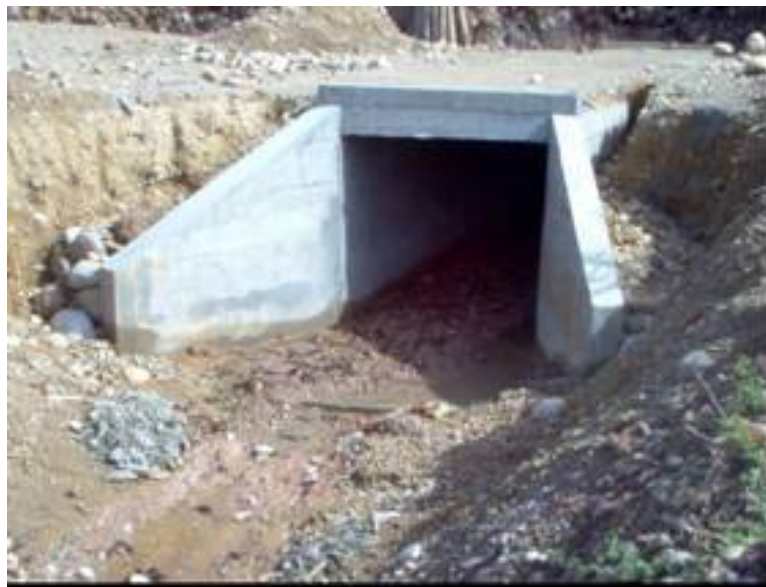
FIGURA 25. BOX COULVERT K 103 + 510
