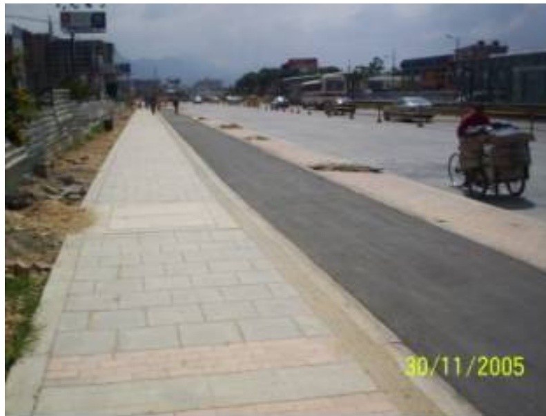
FIGURA 52. ESPACIO PUBLICO TERMINADO
