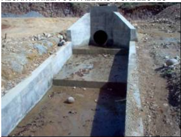
FIGURA 29 ALCANTARILLA CON ALETAS Y CABEZOTES
