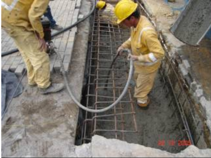
FIGURA 47. FUNDIDA DE SUMIDERO DE AGUAS LLUVIAS
