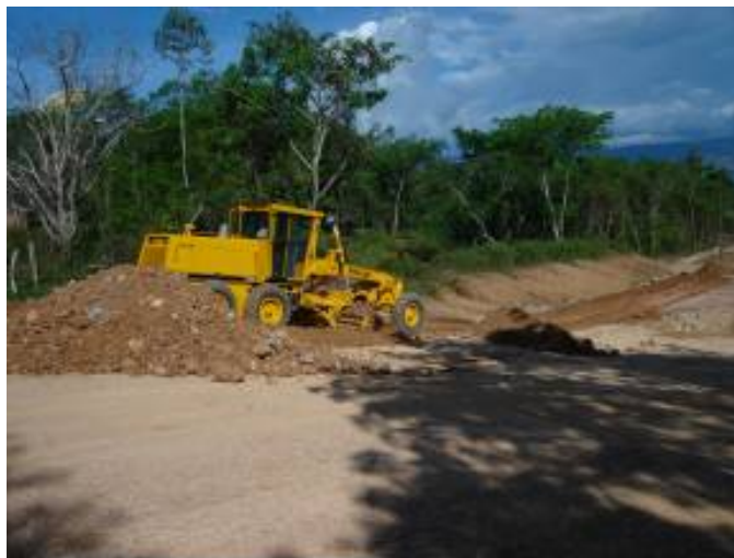
FIGURA 20. ACTIVIDADES EN TERRAPLÉN
