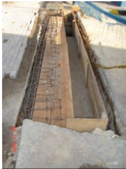
FIGURA 46. FORMALETEADO SUMIDERO AGUAS LLUVIAS
