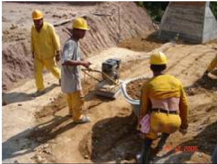
FIGURA 24. RELLENOS PARA ESTRUCTURAS.
