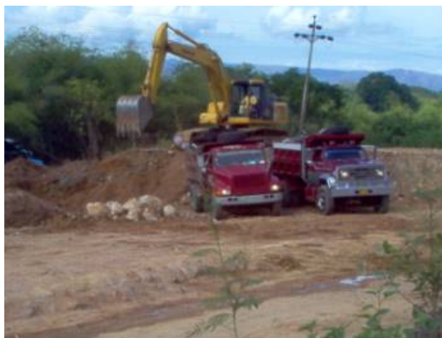
FIGURA 18. EXCAVACIÓN MATERIAL COMÚN.
