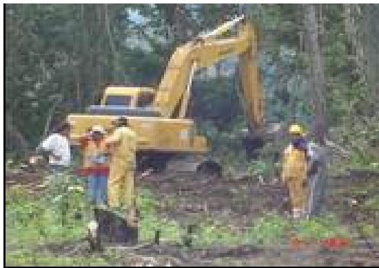
FIGURA 16. DESMONTE Y LIMPIEZA
