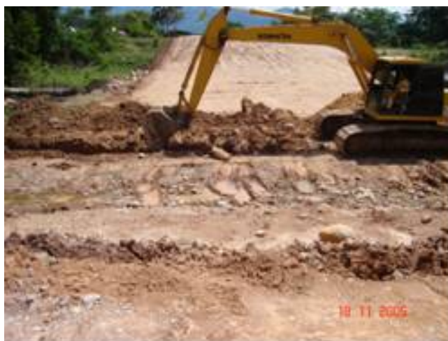
FIGURA 23. EXCAVACIÓN PARA CIMIENTO DE BOX COULVERT.
