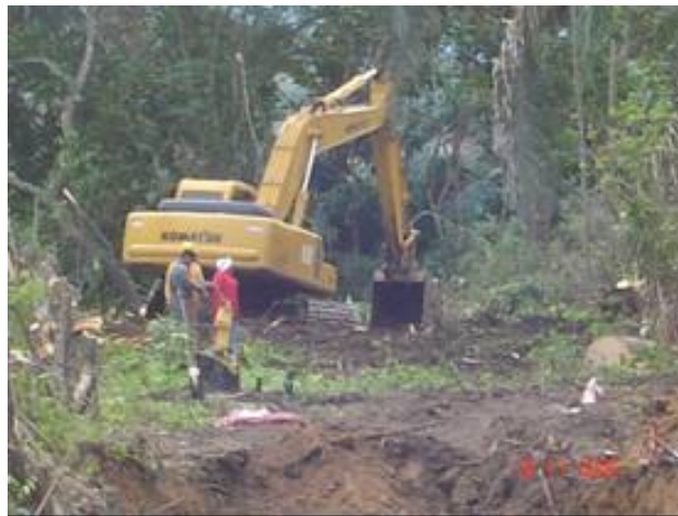
FIGURA 15. TALA CONTROLADA DE FAUNA EN OBRA.
