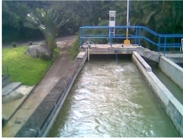
Figura 25. Canal de Aproximación
