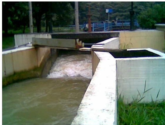
Figura 18. Canaleta Parshall de Pretratamiento
