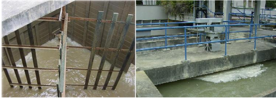
Figura 29. Floculadores Mecánicos
