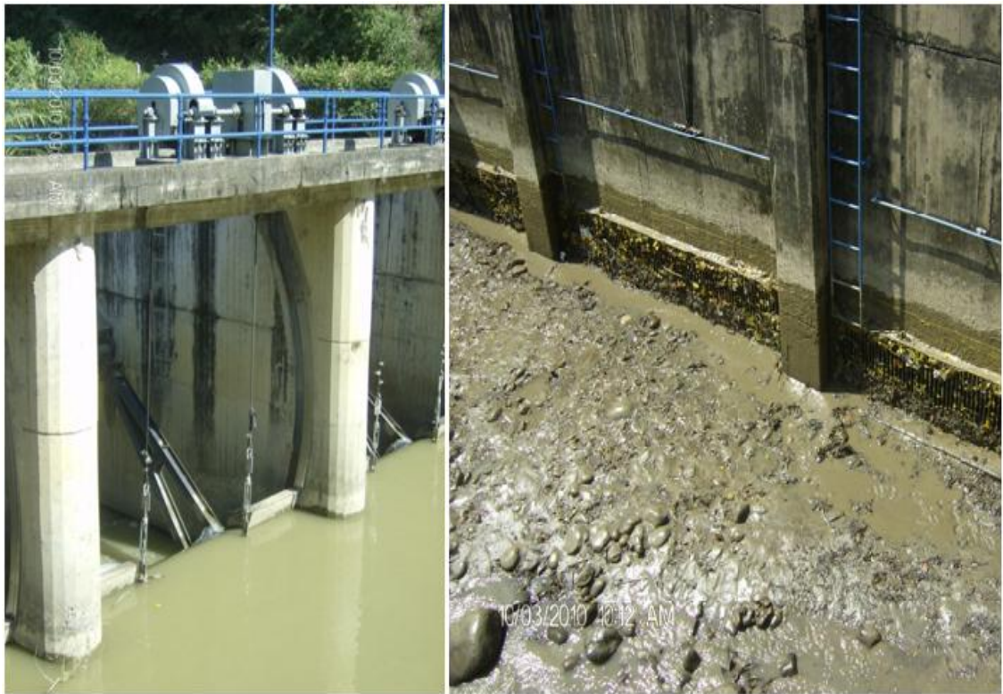
Figura 14. Estructura de Captación, Compuestas Radiales y cámara de Derivación.
