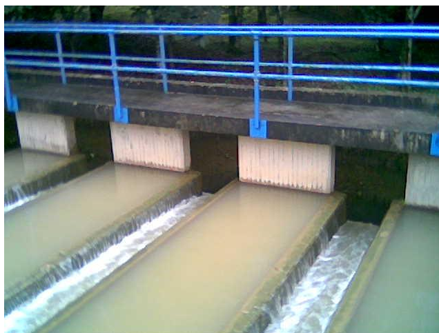
Figura 23. Presedimentadores
