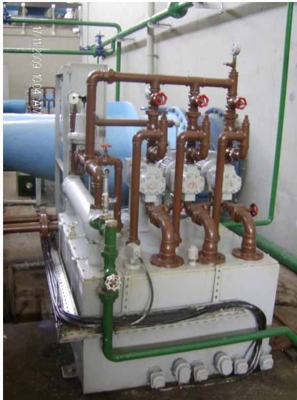
Figura 44. Unidades de Lubricación
