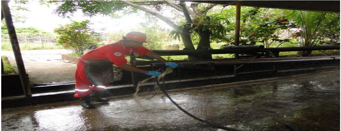
Figura 11. Operario en taller lavando bomba desarenadora
