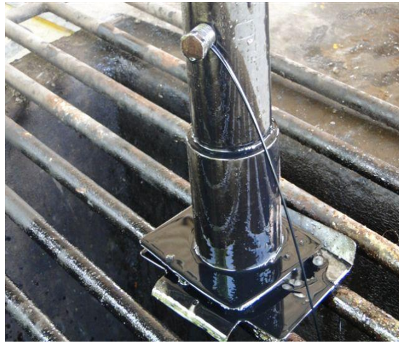
Figura 25.valvula drenando en la operación momentos antes de finalizar
