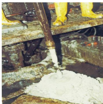
Figura 2. Limpieza con bomba desarenadora
