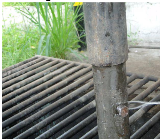
Figura 20. Iniciando descargue la recámara de la bomba desarenadora.
