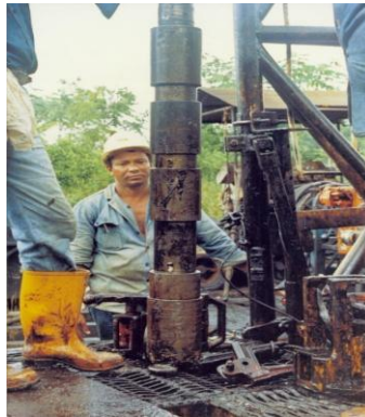
Figura 5. Limpieza de arena con bomba desarenadora
