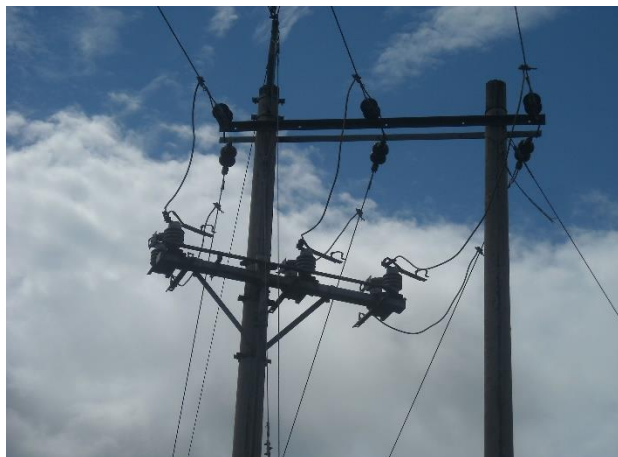
Figura 23. Seccionador tripolar.
