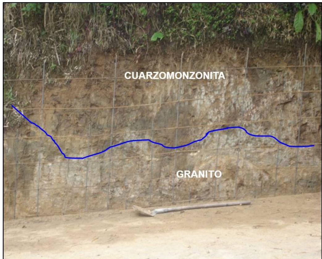
Figura 26. Antiguo afloramiento que muestra el contacto intrusivo entre un granito y una cuarzomonzonita, con venas de cuarzo de tipo hidrotermal. Actualmente tapado con cemento (Foto cortesía de Torres, 2009).
