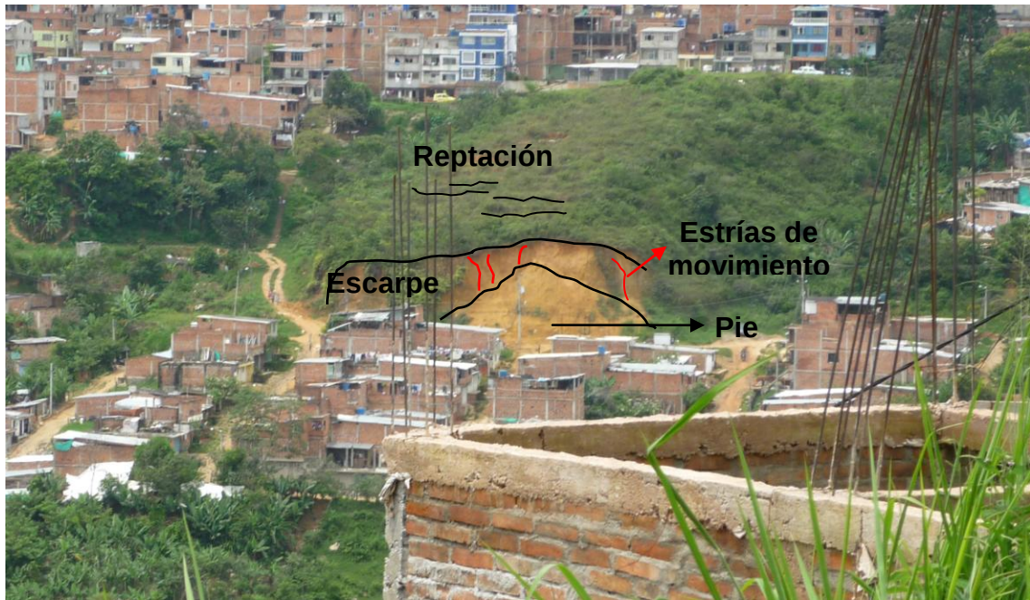
Figura 54. Vista de detalle de un fenómeno de remoción en masa como flujo de escombros. Se observa el escarpe y el pie, además de algunos rasgos como estrías de movimiento. Imagen tomada desde el Barrio Prados del Sur sobre la Carrera 45 frente al Cerro La Cumbre.
