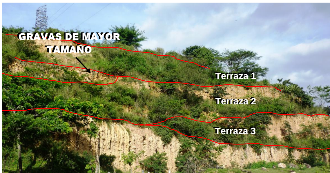
Figura 78. Afloramiento compuesto de arenas con gravas sin geometría definida. Se identifica un nivel con gravas de mayor tamaño en la parte superior de la segunda terraza hacia abajo. Las líneas rojas indican las diferentes terrazas que fueron construidas para la mitigación del riesgo por erosión del talud en época invernal. También se identifican surcos y cárcavas en los diferentes niveles de las terrazas.
