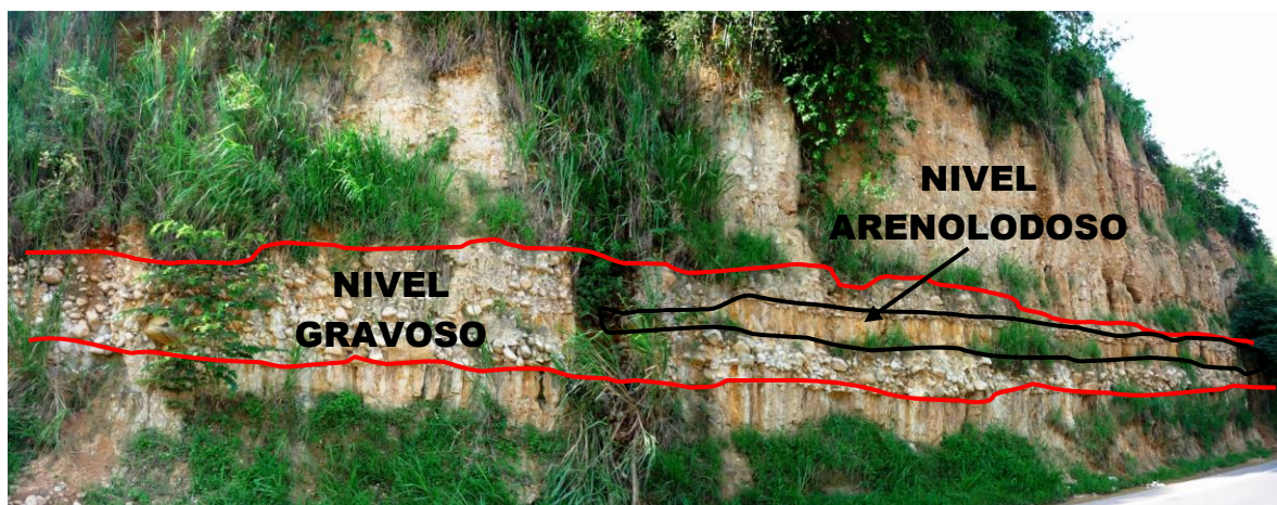
Figura 68. Afloramiento con un nivel potente de gravas el cual se interrumpe parcialmente por un nivel arenolodoso. Costado norte Anillo Vial vía Girón.
