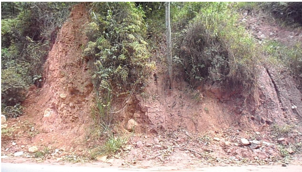
Figura 57. Imagen panorámica del afloramiento ubicado sobre la vía antigua Bucaramanga-Floridablanca, cerca al Barrio Bucarica. Se observa caída de material altamente meteorizado, compuesto de areniscas conglomeráticas y limolitas color violeta.
