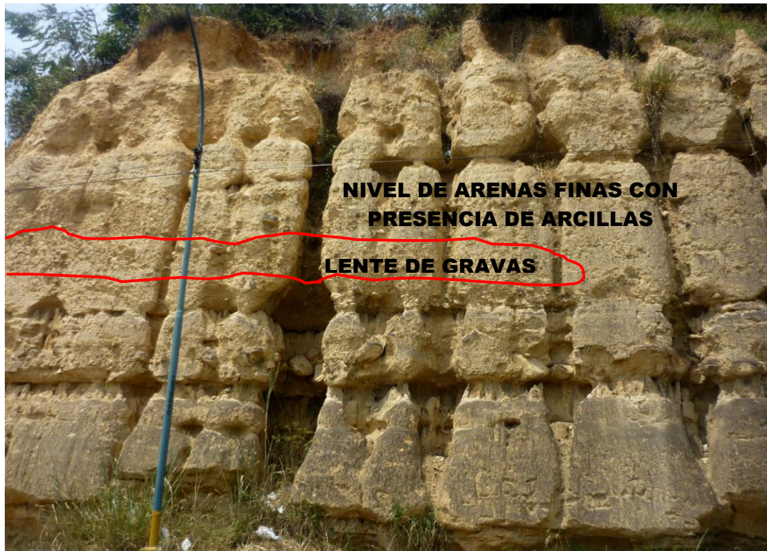
Figura 83. Lente de gravas dentro del nivel de arenas finas. Costado norte Avenida El Papa que conduce al Terminal de Transportes.
