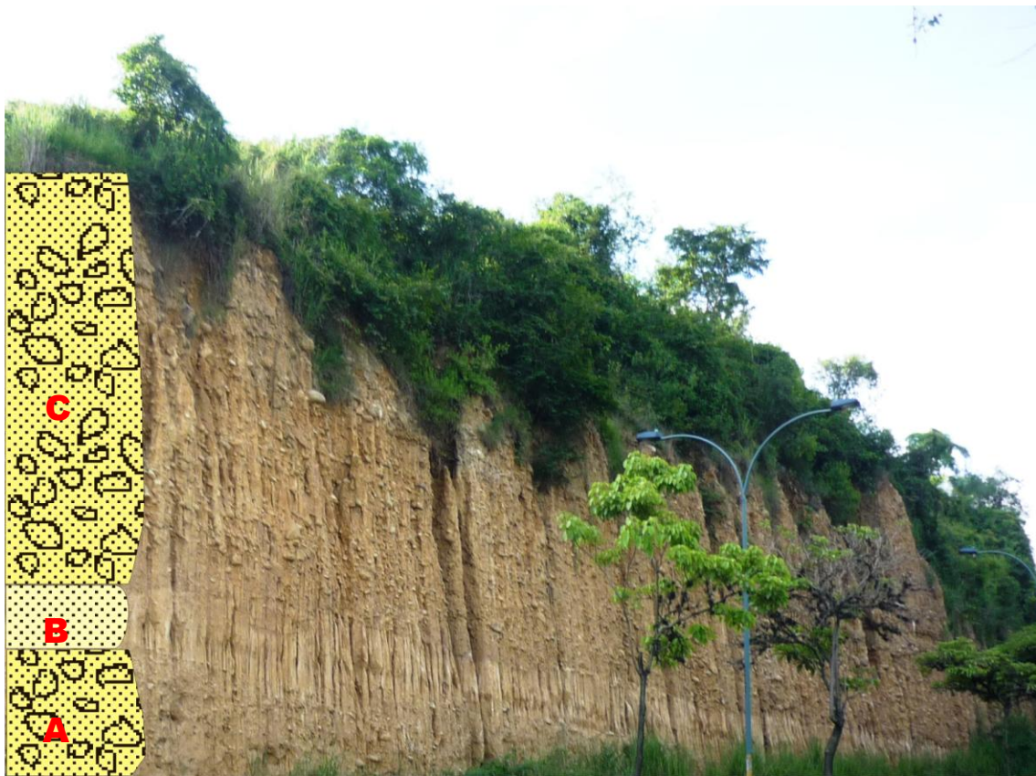
Figura 75. Afloramiento compuesto por arenas con gravas, matrizsoportadas, con clastos subredondeados a redondeados ( A y C ), con un nivel arenolodoso con geometría lenticular y sin continuidad lateral ( B ). Este afloramiento se ubica en el costado norte de la Avenida Metropolitana a 150 m del puente El Bueno.
