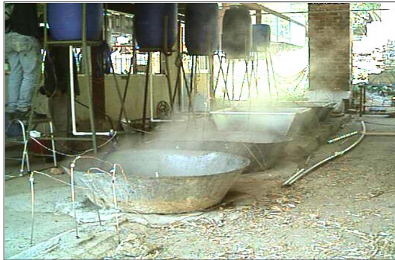
Fig. 11 Vista general de los sistemas de control en operación
