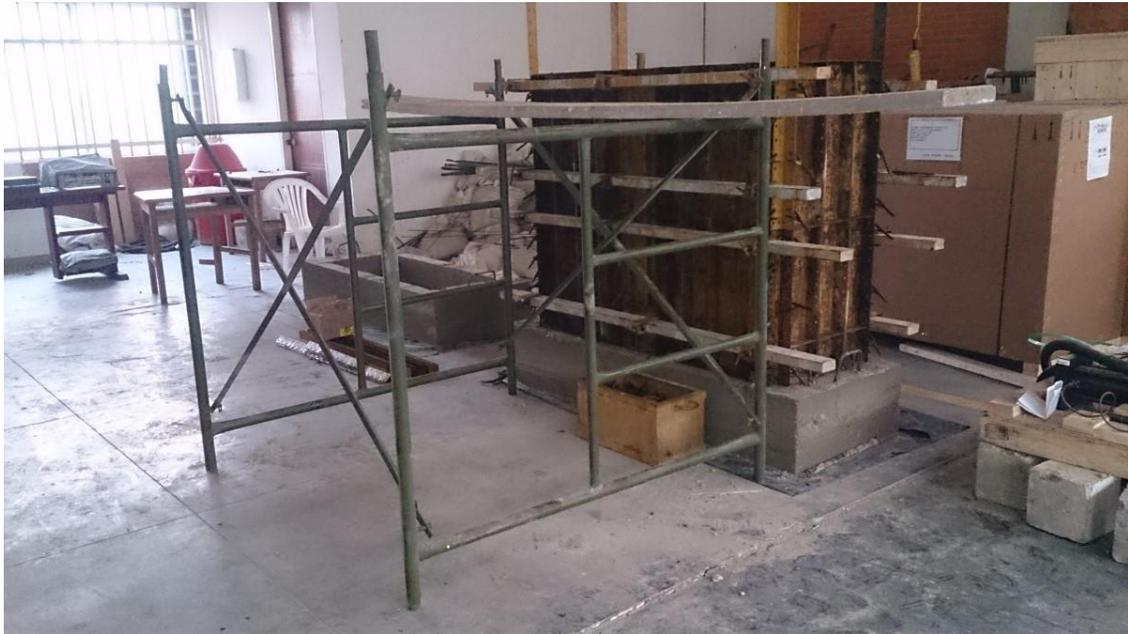
*Figura 55. Regla para controlar el espesor de las capas de tierra.*
