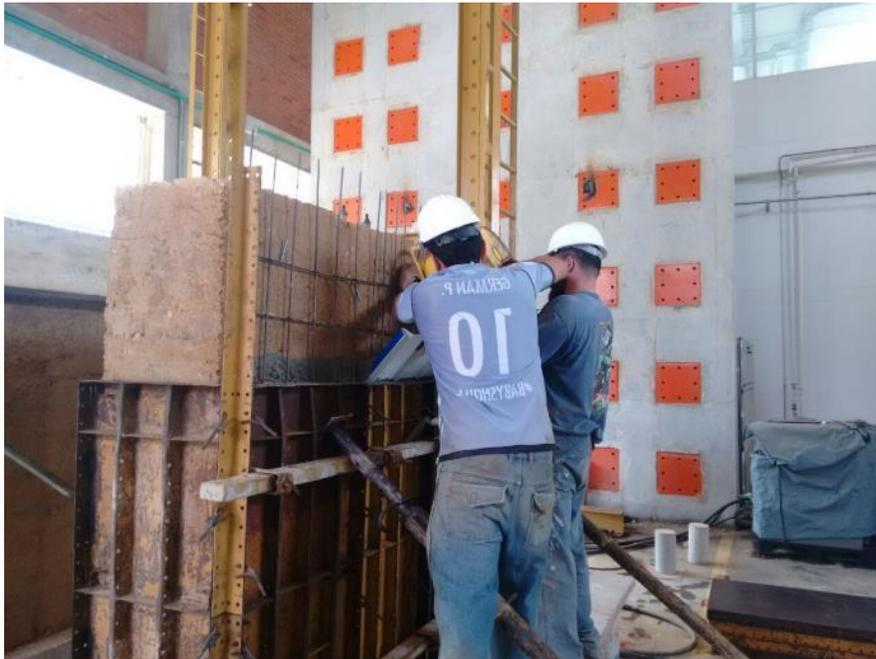
*Figura 62. Apuntalamiento de la viga corona para no cargar el muro*
