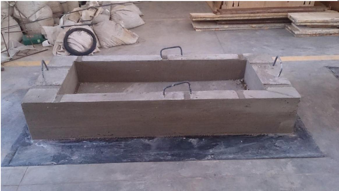
*Figura 54. Formaleteada de los muros.*
