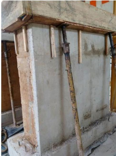
*Figura 63. Aparición de grieta nuevamente, a una altura de unos 50 cm de la corona*
