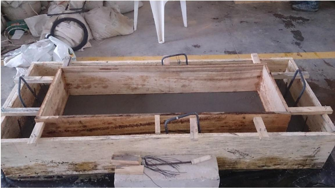
Figura 53. Viga de base fundida.
