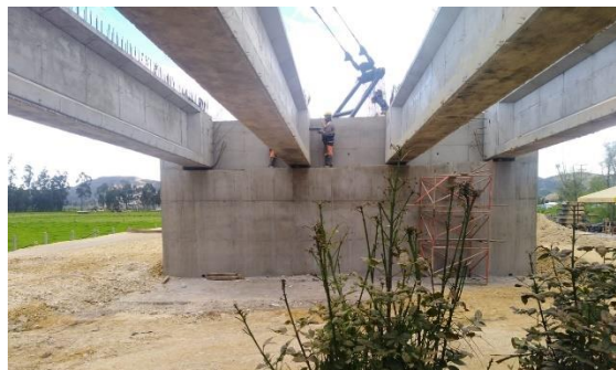
Figura 11. Montaje de vigas postensadas en el Puente 8 - Tramo 9.
