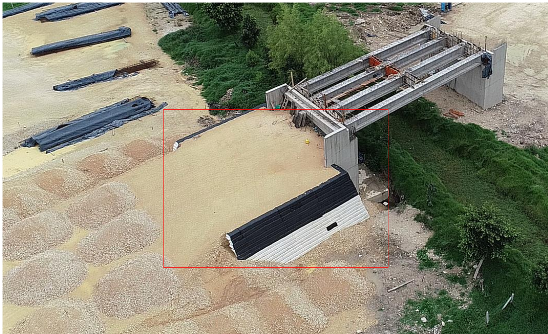
Figura 18. SME Puente 5 Eje 1 Calzada Derecha.
