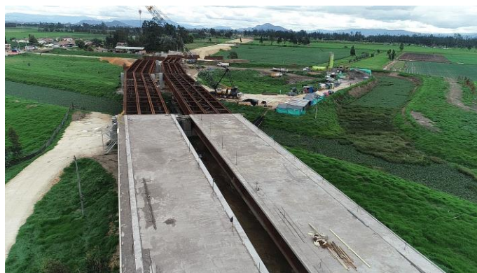
Figura 3. Calzada derecha e izquierda, Tramo 9.
