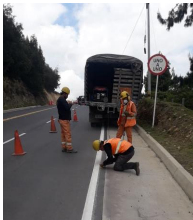
Figura 15 Reparación trabajos realizados en demarcación horizontal.
