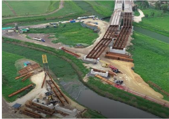
Figura 16. Avance montaje de vigas metálicas Puente 1 Calzada Derecha e Izquierda al 20 de junio de 2019 - Tramo 9.
