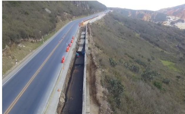
Figura 2. Tercer carril en construcción en el Tramo 8.
