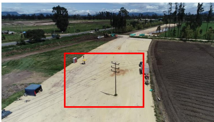
Figura 21. Interferencia presentada en Puente 5 calzada derecha K1+900 – Tramo 9.
