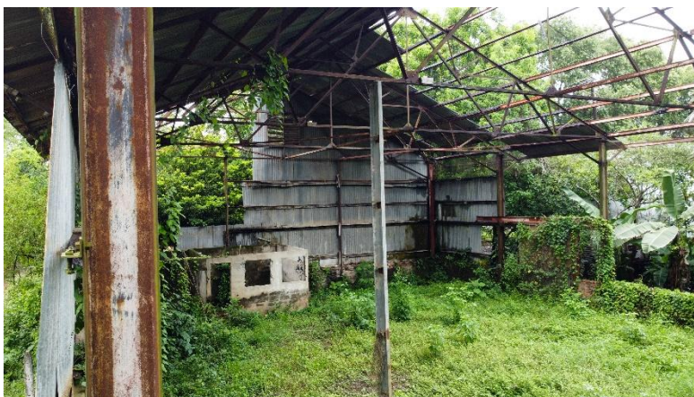
Figura 20 Interior de las bodegas
