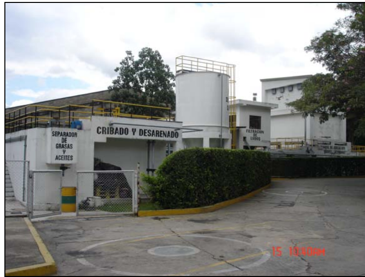
Figura 12. Planta de tratamiento de aguas residuales
