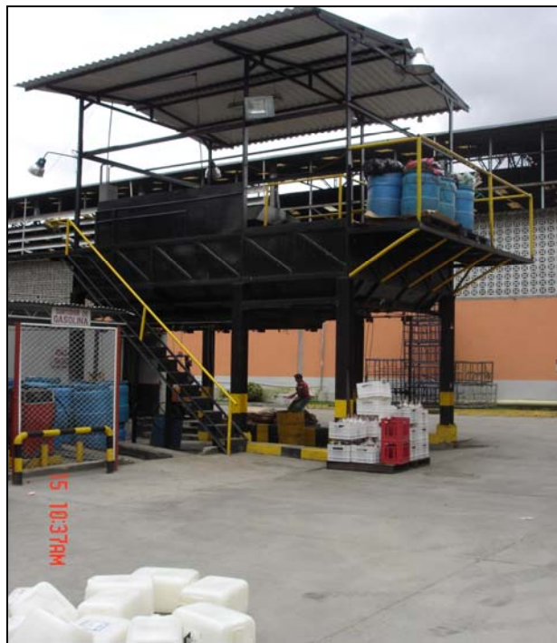
Figura 19. Tolva de almacenamiento temporal de residuos sólidos
