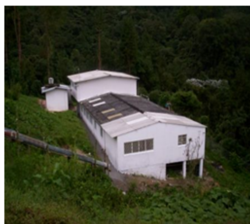
Después de la Construcción
