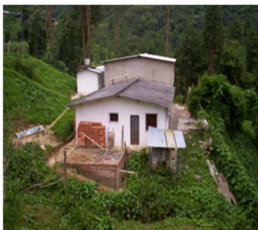
Construyendo el nuevo salón y el restaurante escolar
