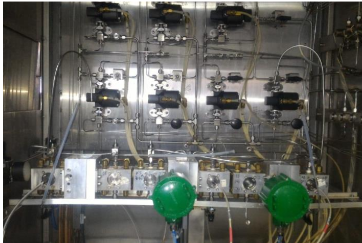
Figura 8. Celda de medición de calidad
