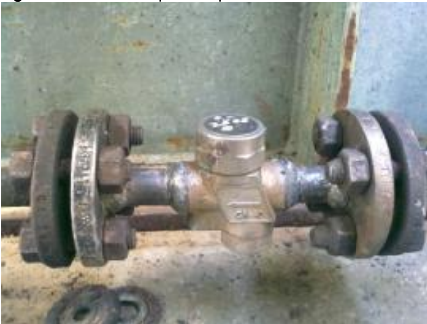
Figura 14. Nueva trampa de vapor ubicada en E-2515C.
