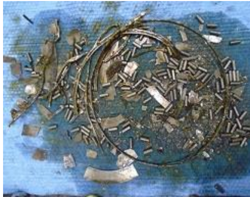
Destrucción interna del rodamiento de acople gear box -vástago
