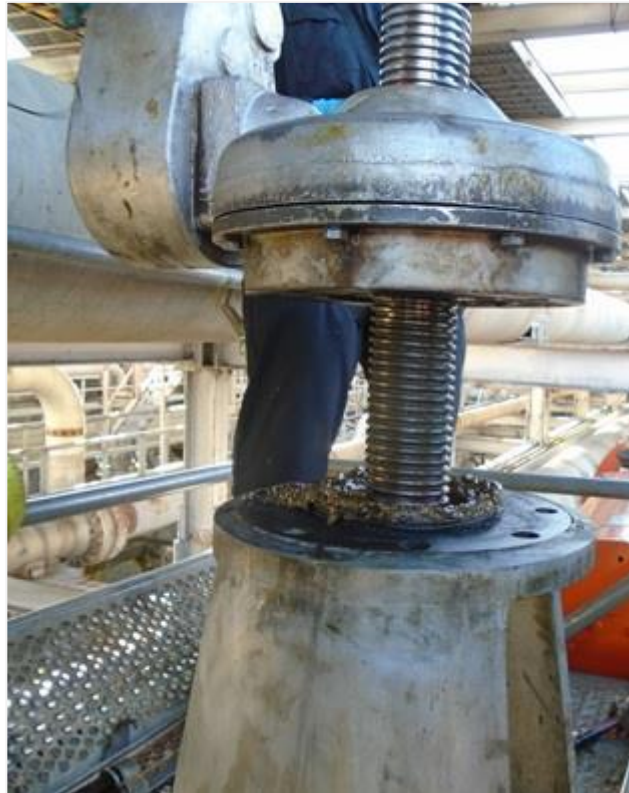
Figura 1. Gear box conectado al vástago de la válvula
