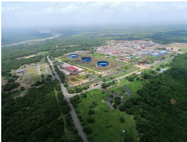
Figura 6. Instalaciones del CPF Cusiana Ecopetrol S.A.
