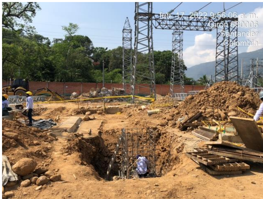
Figura 18. Cimentaciones de bahía de líneas.
