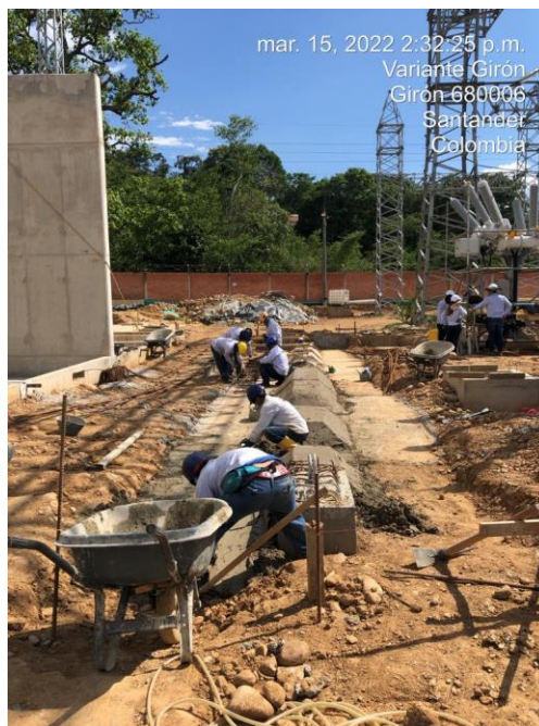
Figura 21. Solado de la carrilera principal.
