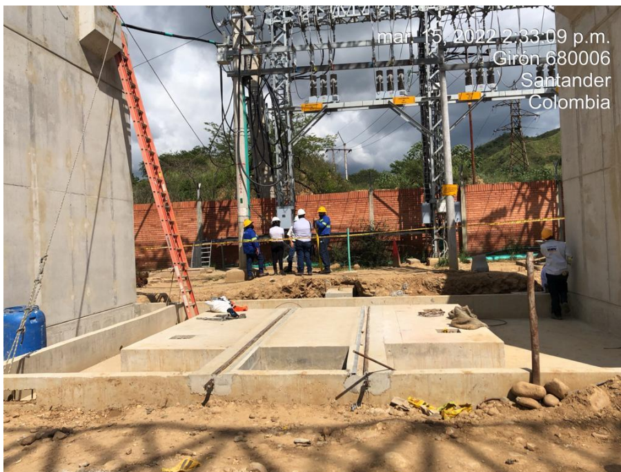
Figura 19. Cimentación del transformador T3.
