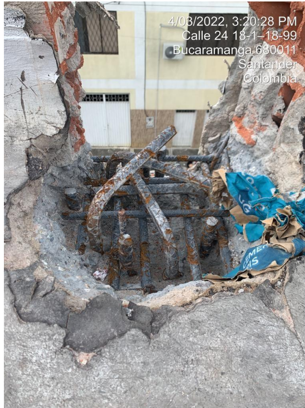
Figura 11. Distribución de acero en columnas a prolongar.
