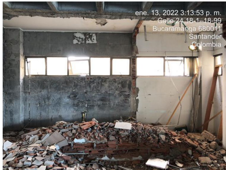
Figura 8. Demolición de mampostería.
