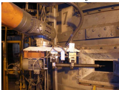
Figura 5.15: Robot en trabajo de fundición
