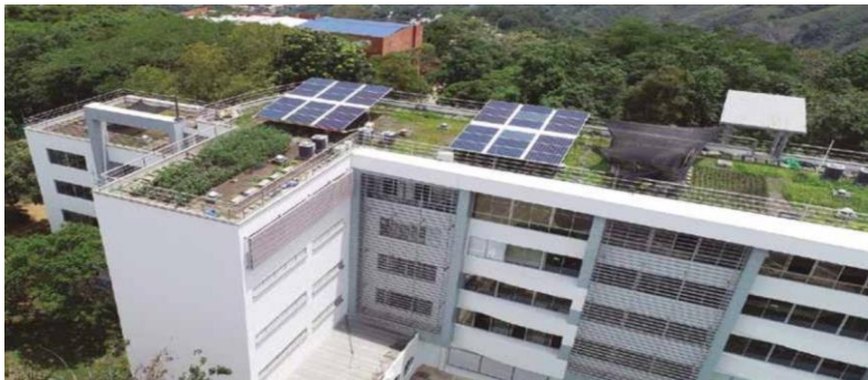
Figura 6 Terraza verde superior Escuela de Ingenierías Eléctrica, Electrónica y de Telecomunicaciones
