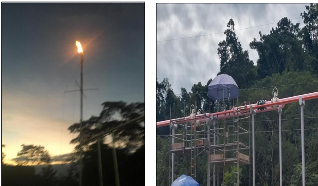
Figura 5. Sistema de medición y tea módulo 1. Adaptado de: Departamento Ingeniería de ECP
