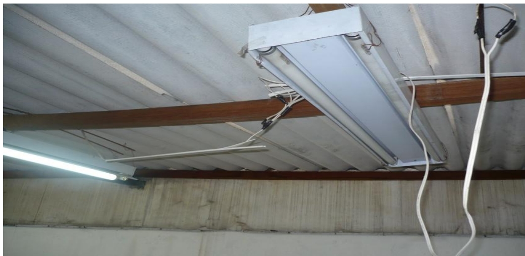
Fotografía 2. En la fotografía se observan conexiones eléctricas inseguras. 25 enero 2011
