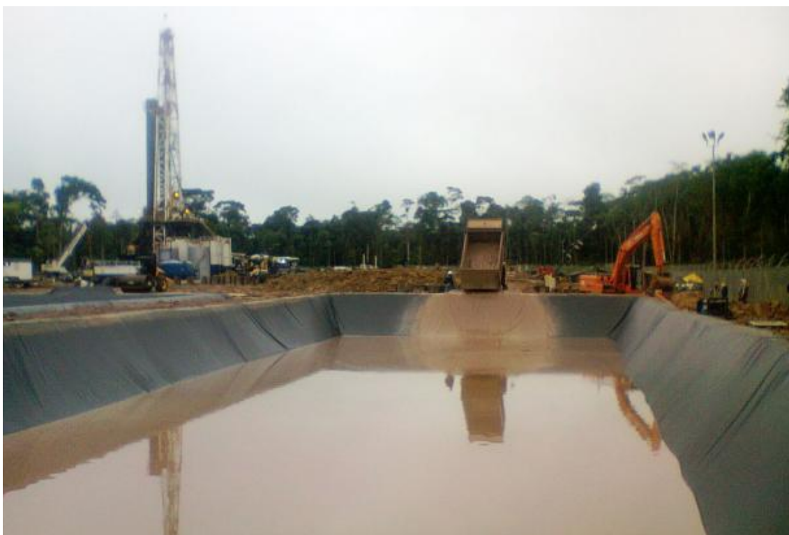
Figura 50. Piscinas de almacenamiento de fluidos resultantes de la perforación 93
