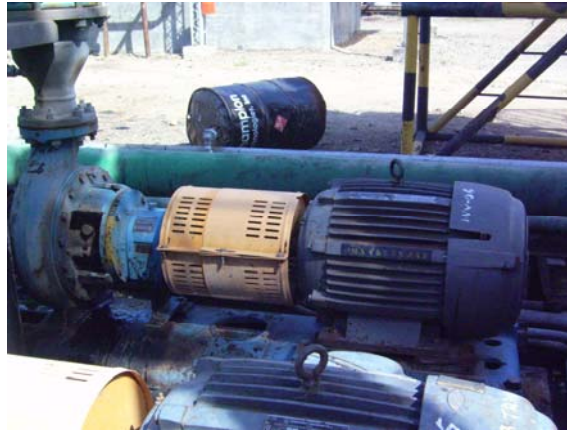
Figura 21. Bomba de transferencia. Campo Jazmín.
