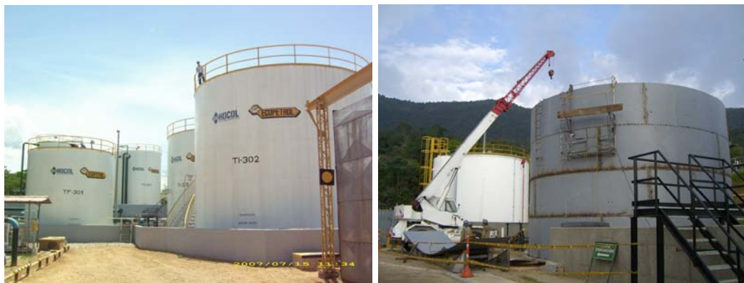
Figura 8. Tanques desnatadores
