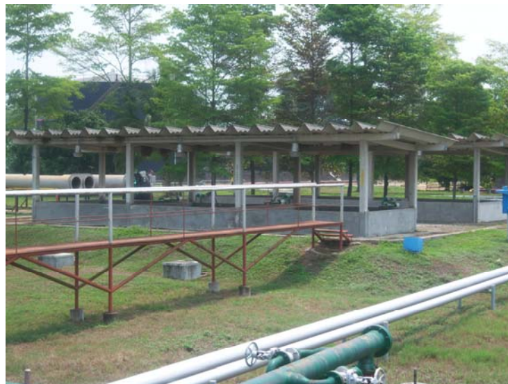
Figura 30. Lechos de secado AD-711
