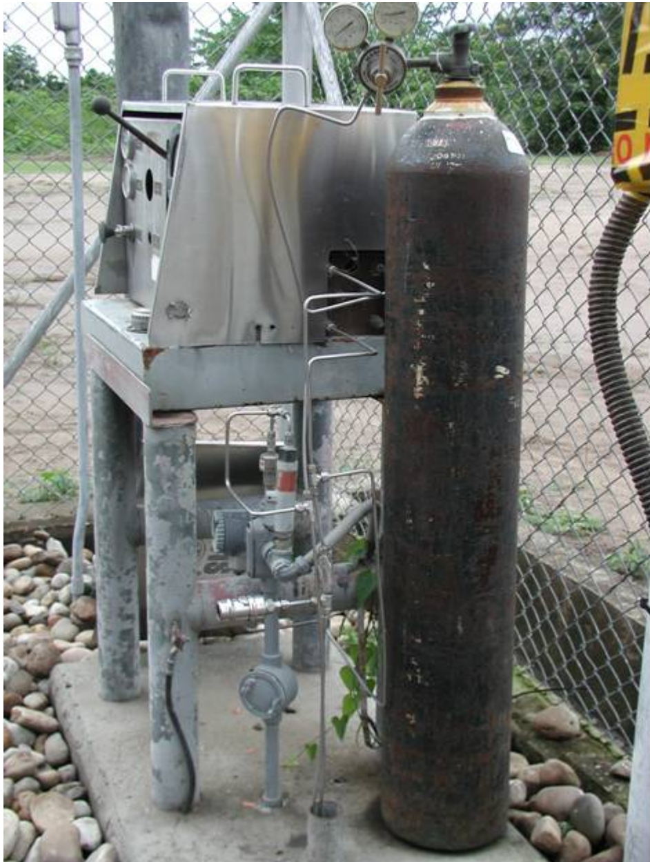
Figura 17. Vista lateral de la instalación del Panel OTIS.
