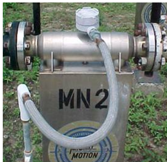
Figura 11b. Fotografía del medidor de flujo másico Micro Motion instalado en el pozo MN-21
