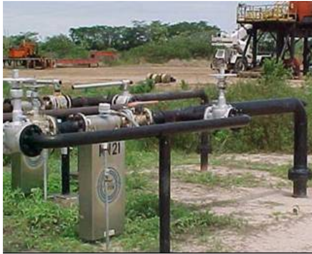
Figura 11b. Fotografía del medidor de flujo másico Micro Motion instalado en el pozo MN-21
