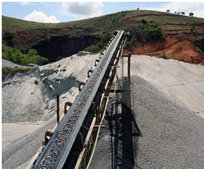
Figura 44. Banda transportadora de rocas.
