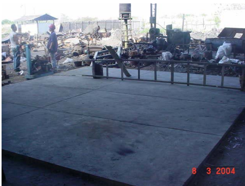
Figura 17. Terminación del piso de concreto para el acero
