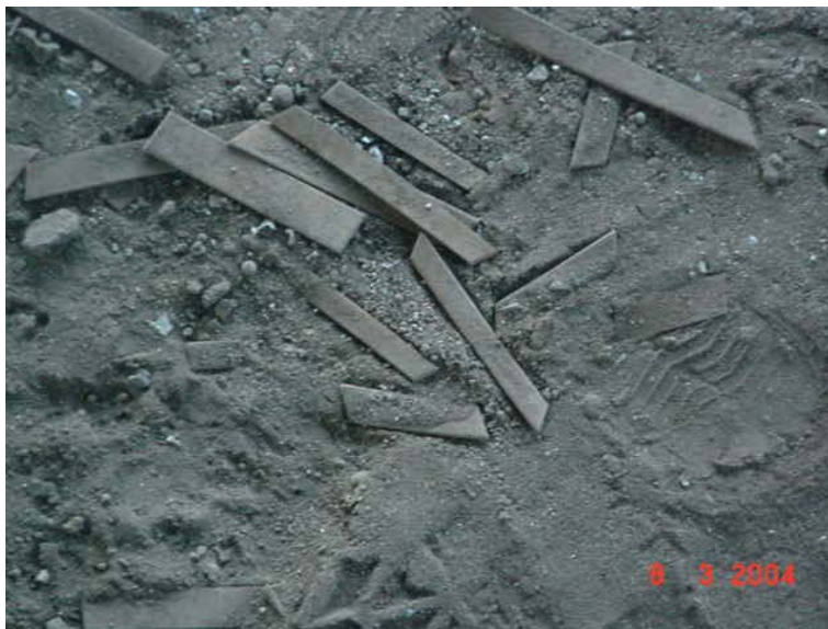
Figura 16. Situación inicial. Pérdida de material
