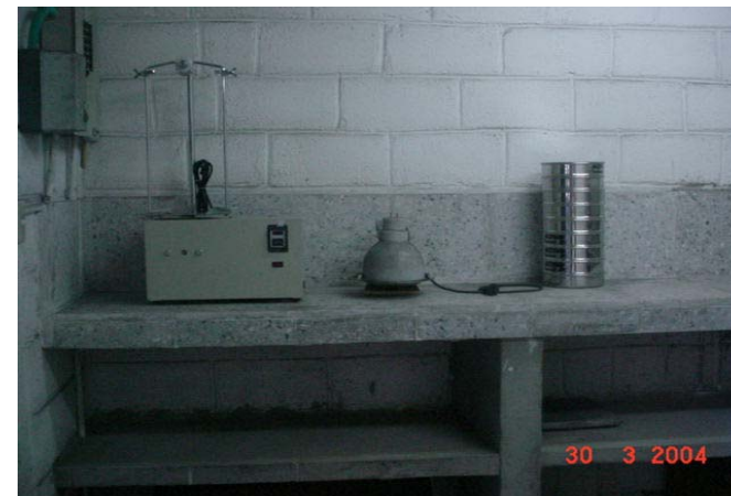
Figura 23. Instalación de equipos
