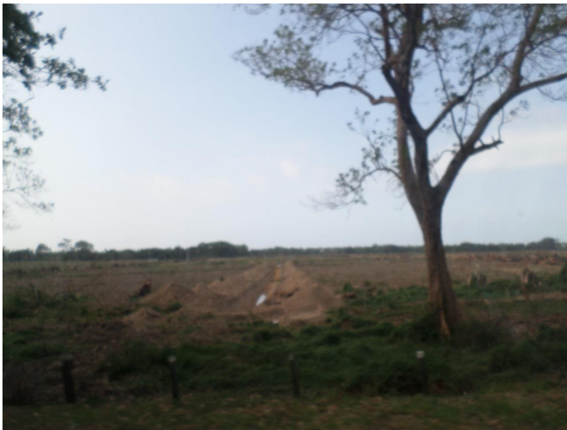
Figura 21. Observación directa erosión del terreno, estribaciones de la Sierra en la vía Guachaca - Palomino. Septiembre 2015.
