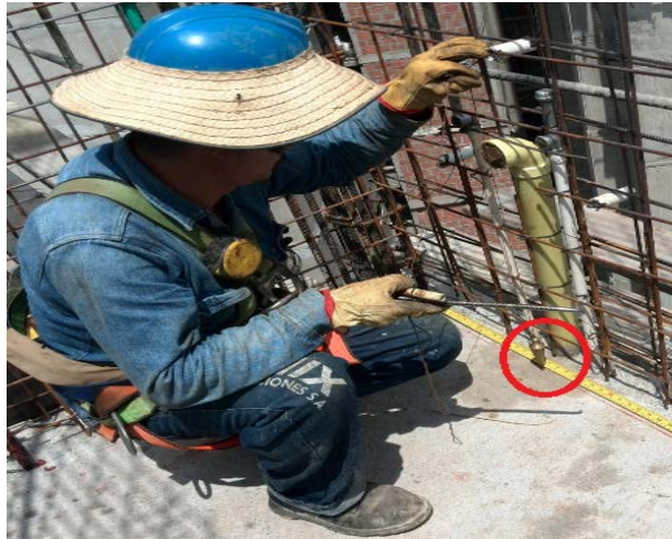
Figura 25. Aplome de parales hidráulicos agua fría
