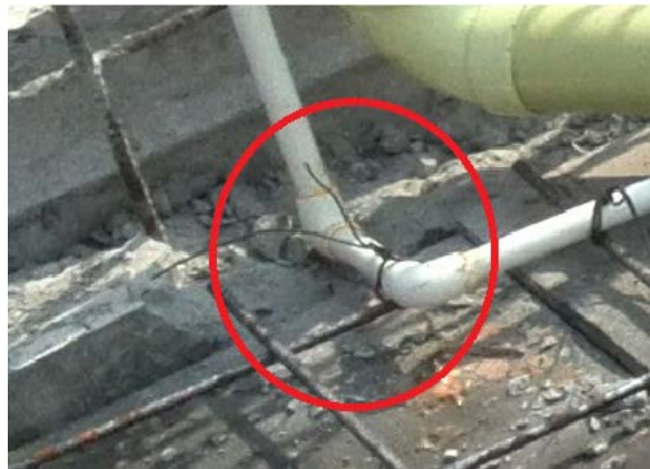
Figura 8. Muro descacilado para ubicar tubería hidráulica.
