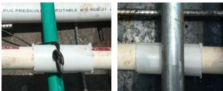
Figura 11. Detalle separadores tubería CPVC
