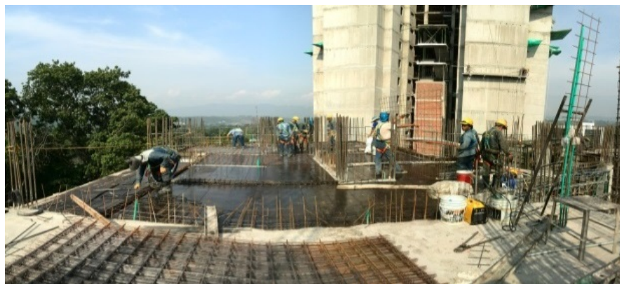
Figura 6. Placa nivelada, enmallada y con ACPM.
