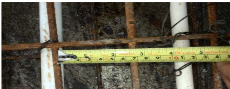
Figura 12. Detalle separación PVC-CPVC.
