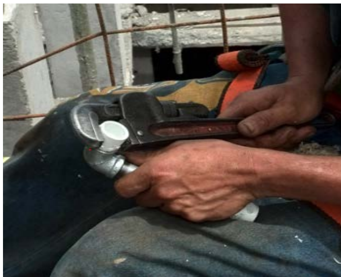
Figura 23. Apretando codo HG y adaptador con llave de tubo
