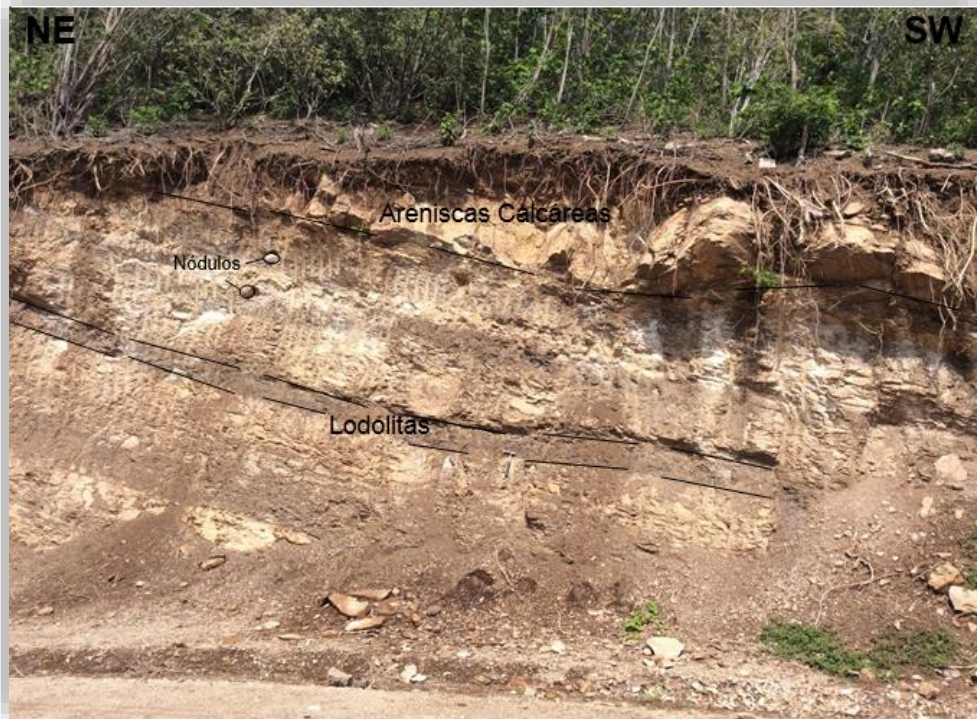
Figura 19. Intercalaciones de areniscas calcáreas y lodolitas calcáreas con presencia de nódulos. Formación la Luna (K21). Vereda Alto de las Flores. Estación CC04, 1 553 577m.N y 1 095 535m.E.
