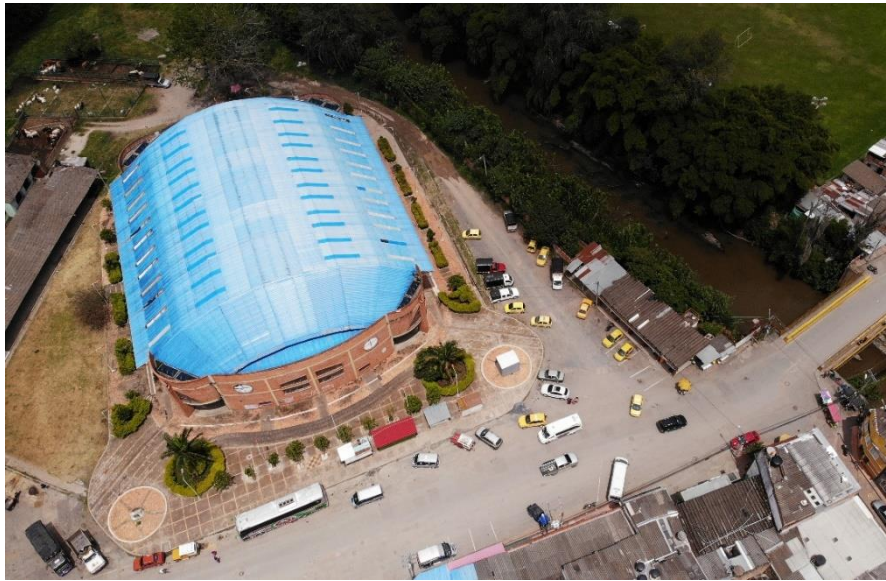
Figura 8. Vista aérea del Coliseo Municipal
