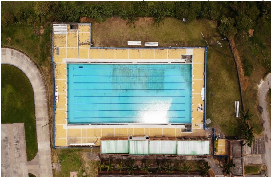
Figura 16. Vista aérea de la Piscina Olímpica del municipio de Moniquirá.
