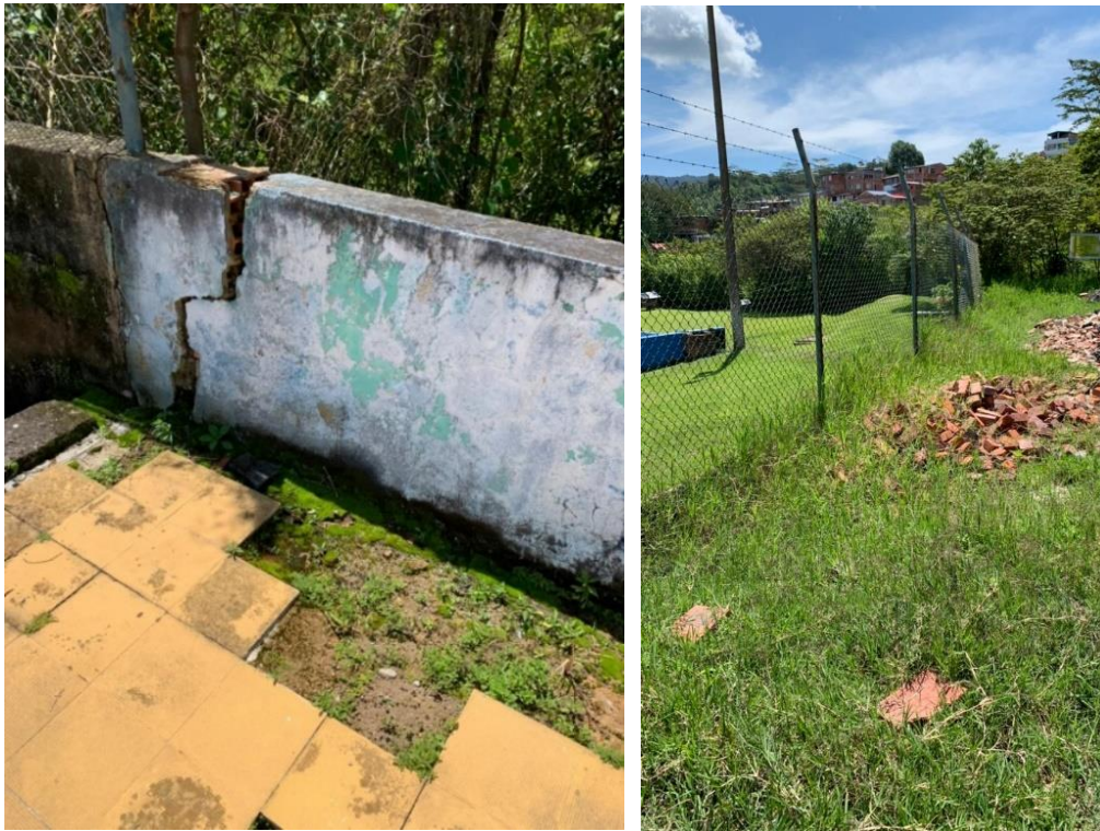
Figura 17. Visita a las instalaciones de la Piscina Olímpica del municipio de Moniquirá.
