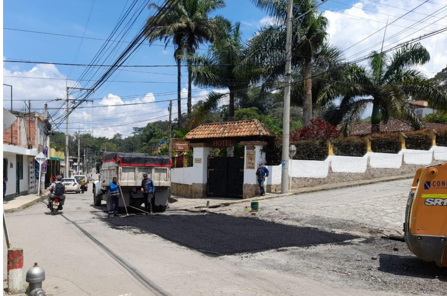
Figura 5. Aplicación de la mezcla asfáltica MDC-19 realizada por el contratista Diapofy S.A.S, sobre la Cra. 9.
