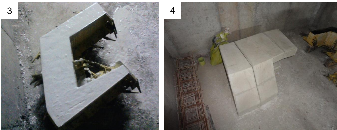
Figura 48. Fundición del módulo en la formaleta.
