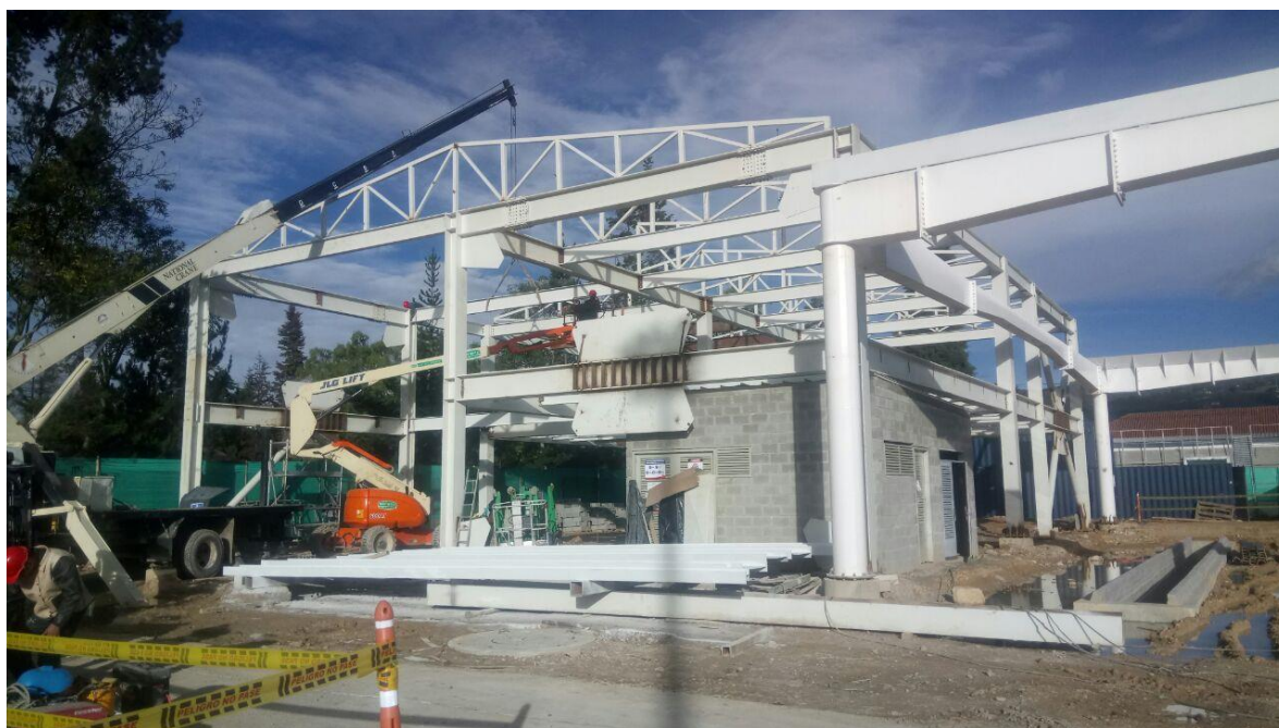
Figura 1. Construcción de la estructura del edificio
