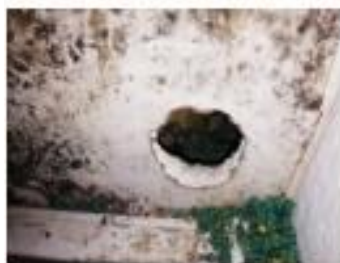
Figura 8. Desratización y Control de Roedores
