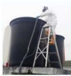
Figura 11. Lavado y Desinfección de Tanques de Agua Potable
