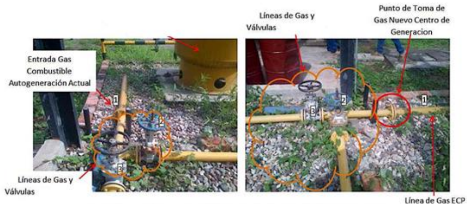
Figura 12. Punto de conexión del gas combustible para centro de generación Casabe
