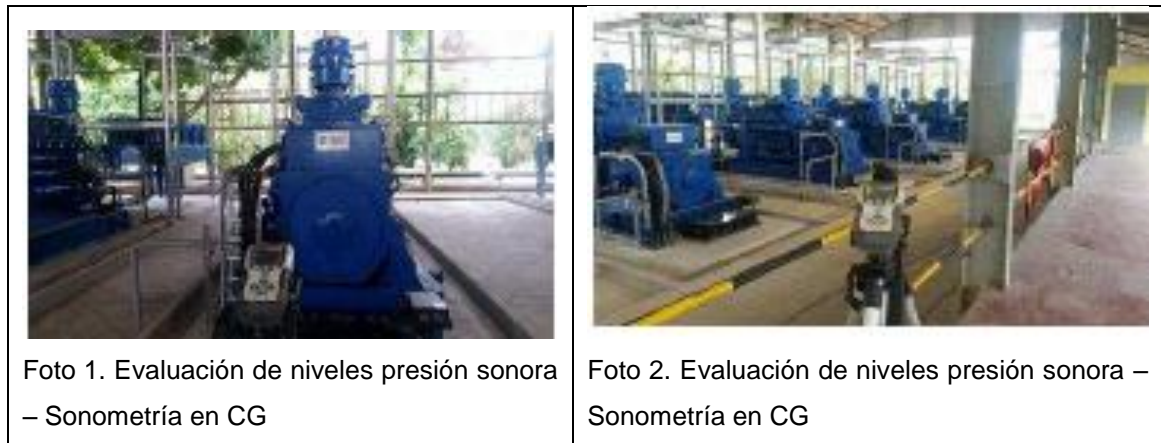
Figura 18. Evaluación de los niveles de ruido en uno de los centros de generación de energía eléctrica
