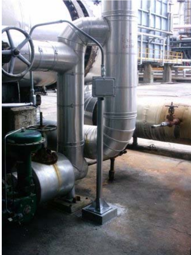
Fig.22 Juntión Box con pedestal y soporte
