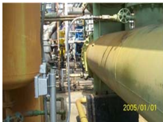
Fig. 23 Probeta completamente instalada
