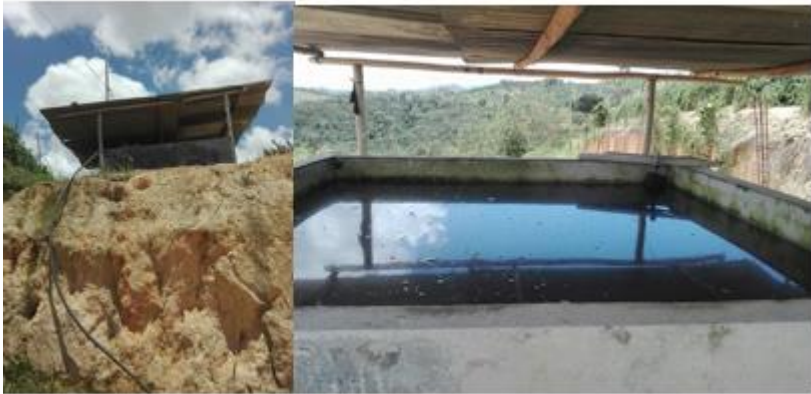
Figura 5. Reservorio de agua proveniente del pozo ubicado en zona rural de Lebrija
